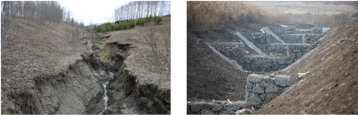
Figura 3. Cárcava de erosión en un suelo Molisol de la provincia de Heliangjiang (izquierda); recuperación de una cárcava con “peines” y “gaviones” en el mismo valle (derecha).
